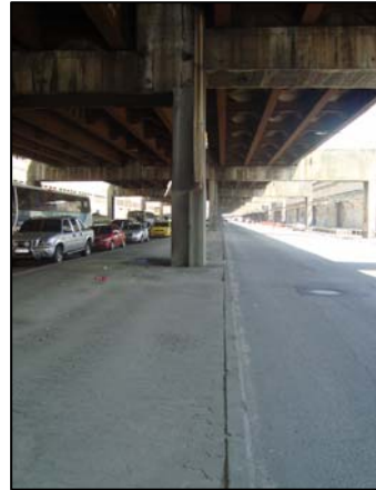
Visão do canteiro central da Av. Rodrigues Alves no setor A, embaixo do Elevado da Perimetral.
